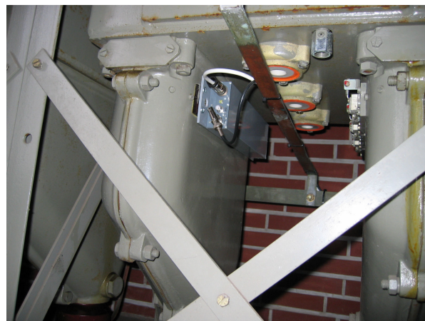
Figur 17, Reyroll med strømsensor
